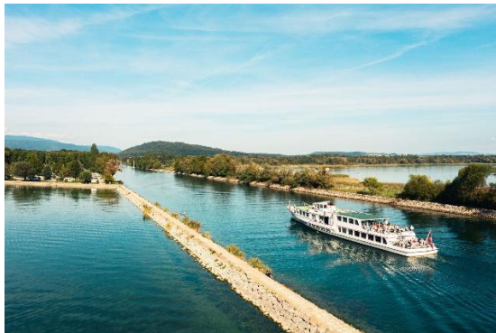
Verbindungskanal zwischen 2 Seen
